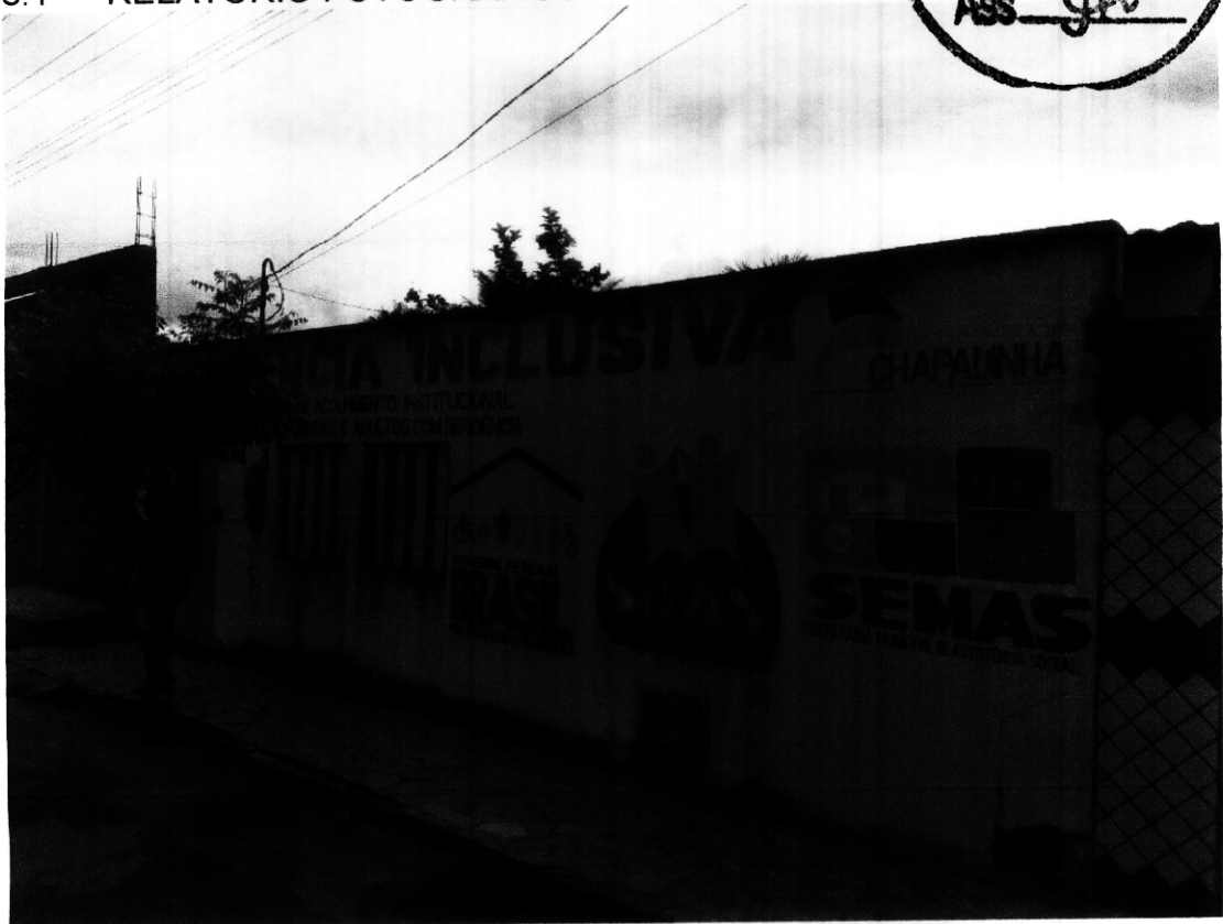
Fachada Fonte: Acervo Técnico (2024)
